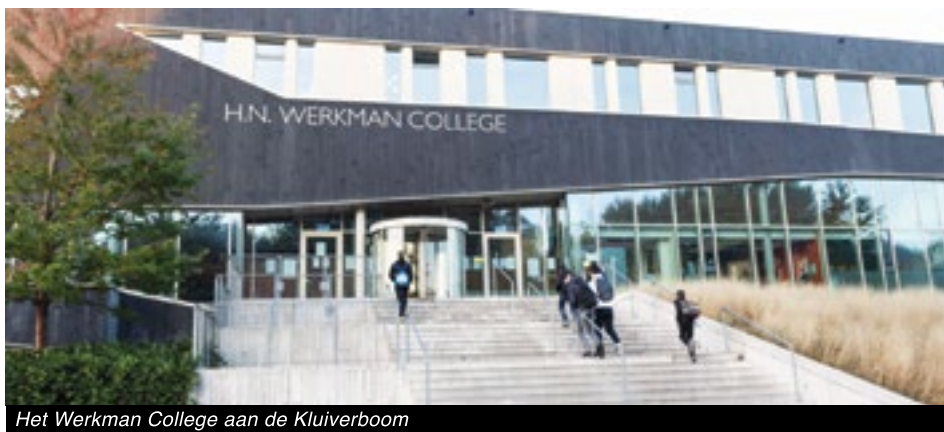
Het Werkman College aan de Kluiverboom
