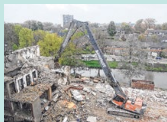
Aan het begin van de wijkvernieuwing werd Huize Patrimonium gesloopt. Hans nam deze foto vanaf het dak van De Es. Hij houdt erg van het vogelvlucht perspectief.
