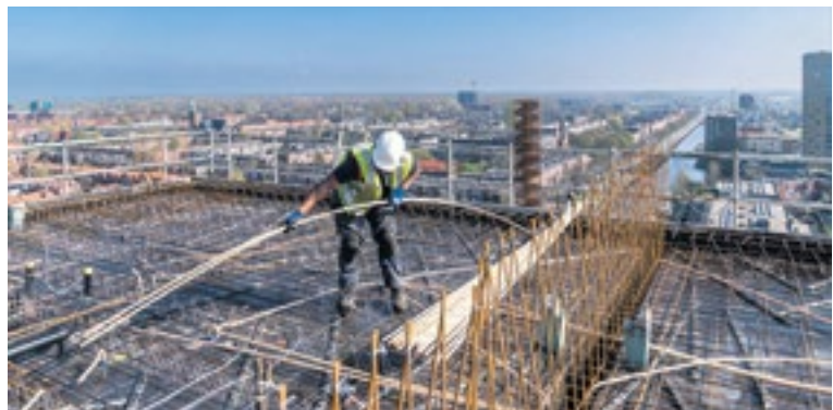
Werkzaamheden nieuwbouw Vrijdemalaan. Foto: Nijestee
