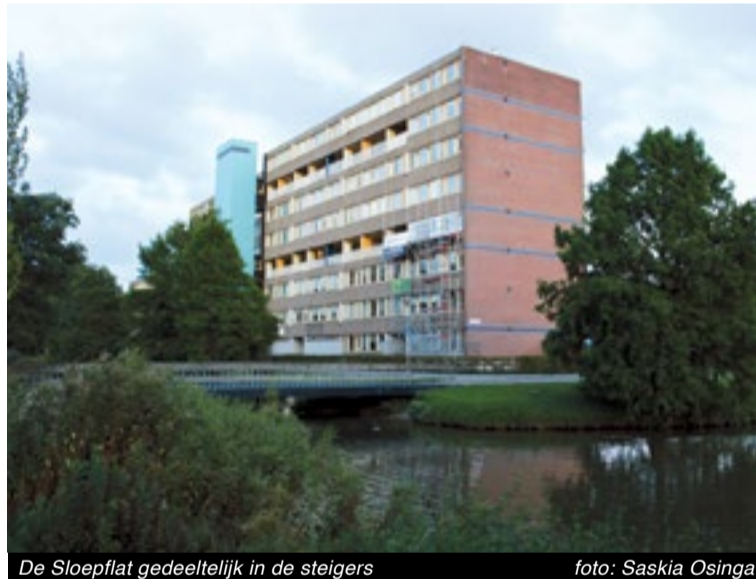
De Sloepflat gedeeltelijk in de steigers
