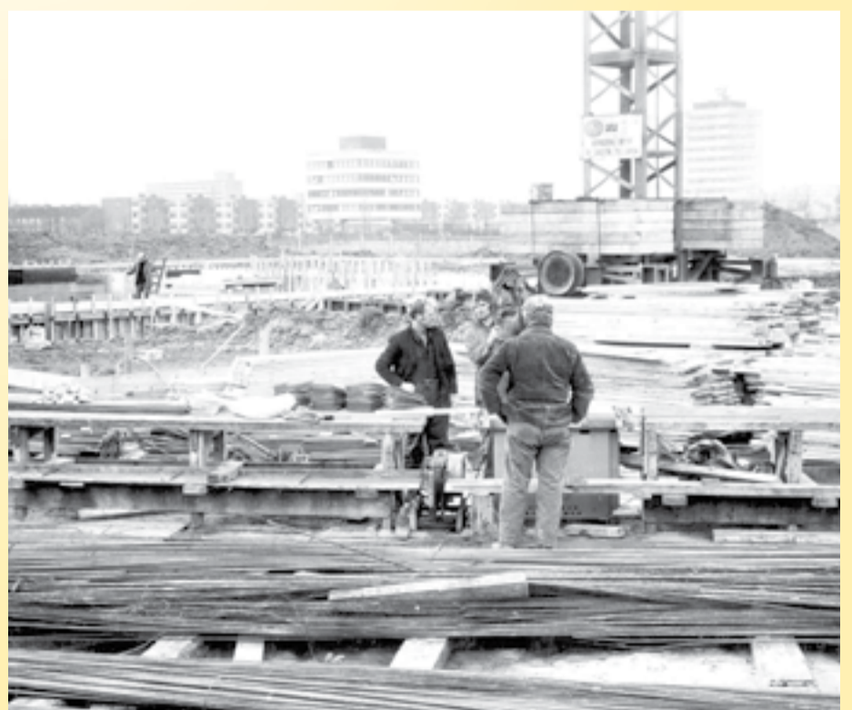
De Parrel in aanbouw. Beeldbank Groningen foto D. van der Veen
