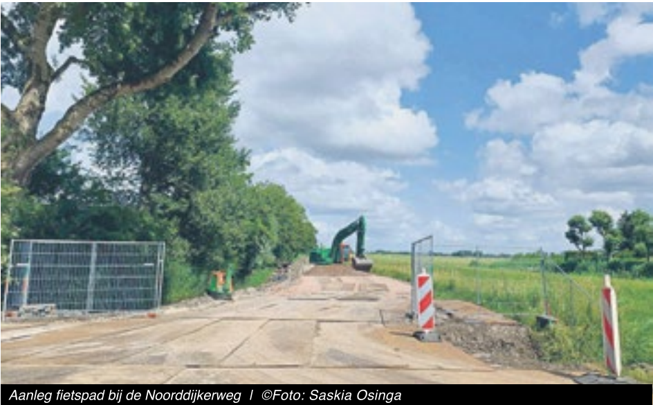
Aanleg fietspad bij de Noorddijkerweg | ©Foto: Saskia Osinga
